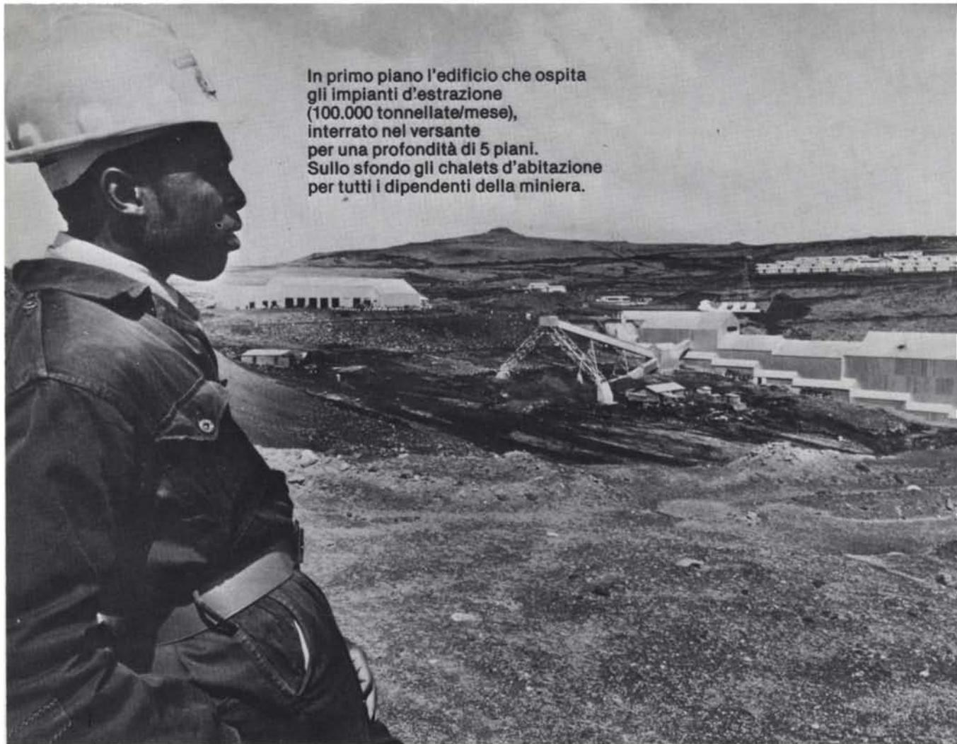
In primo piano l'edificio che ospita gli impianti d'estrazione (100.000 tonnellate/mese), interrato nel versante per una profondità di 5 piani. Sullo sfondo gli chalets d'abitazione per tutti i dipendenti della miniera.
