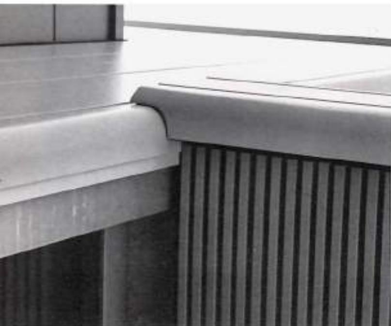
Particolare del raccordo tra la facciata e la pensilina dell'ingresso. Le strutture utilizzate sono industrializzate, fabbricate cioè in serie ma in base a progetti appositamente elaborati per la Mostra del Gioiello Valenzano.
